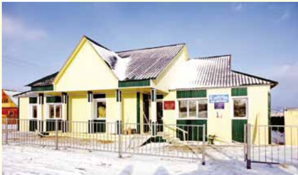
Отремонтированное здание амбулатории в с. Иволга
