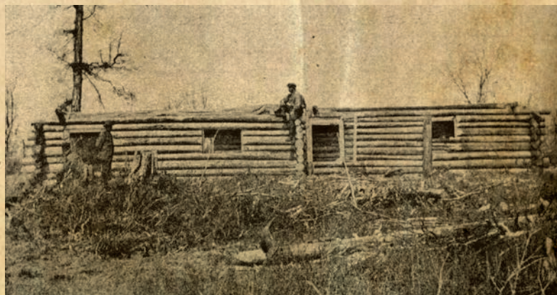
← СТРОИТЕЛЬСТВО ПИТОМНИКА ДЛЯ ИЗУЧЕНИЯ СОБОЛЕЙ
