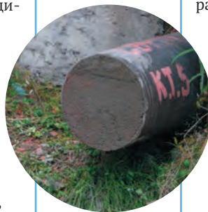
↑ ТРУБА, ВЫВОДЯЩАЯ СТОЧНЫЕ ВОДЫ В РУЧЕЙ ГОРЯЧИЙ, ЗАМУРОВАНА В 2014 Г.
